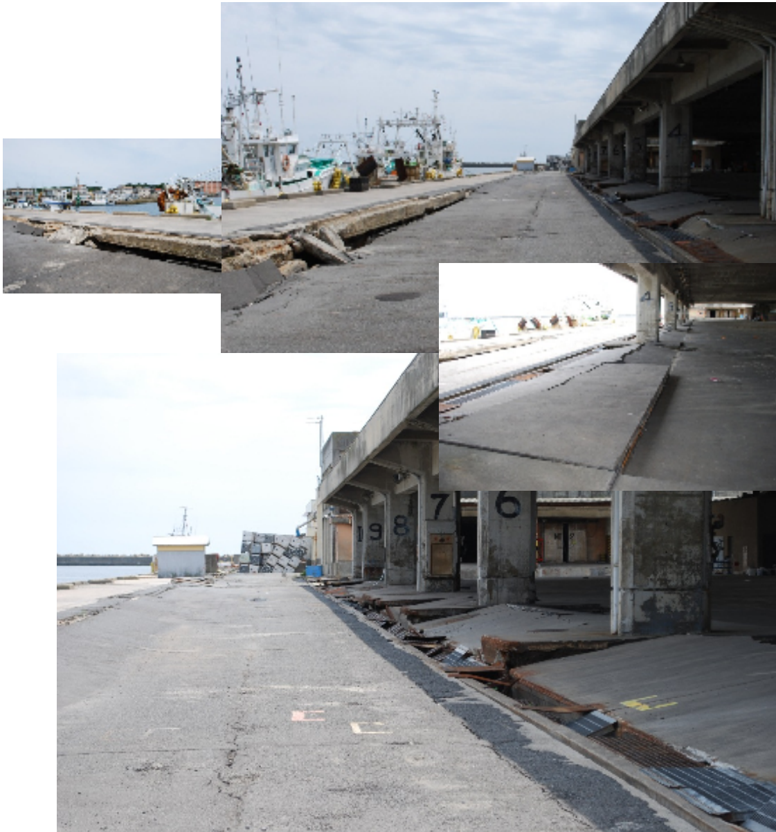
(小名浜港第一埠頭：地盤沈下によって使用不可能な状態が続いている 平成23年6月17日筆者撮影)
